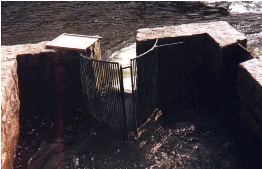
Figura 7: Trampa tipo “V” en la escala de artesas de Ximonde.
