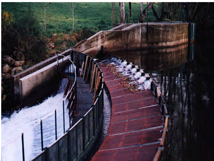
Figura 6: Presa y Estación del Liñares.
