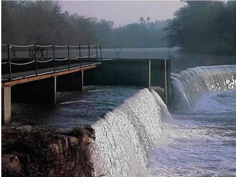
Figura 5: Presa de Ximonde.
