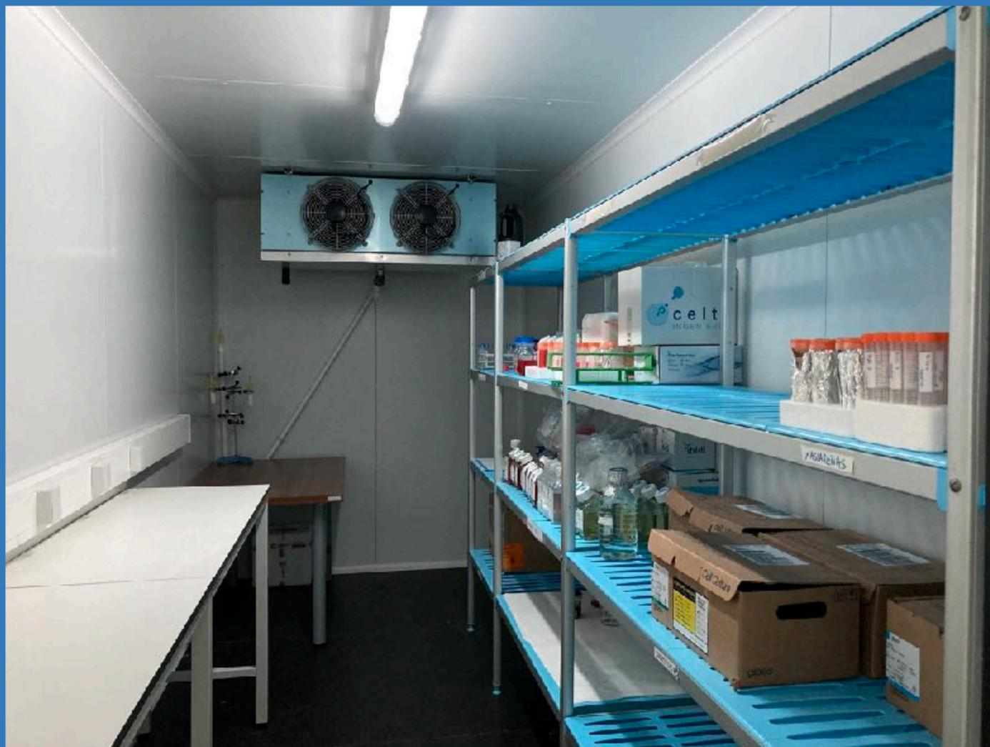
*El CiQUS dispone de dos cámaras frías (más de 20 m<sup>2</sup>) para almacenaje y manipulación de compuestos y materiales a baja temperatura. Se trata de espacios térmicamente aislados dotados de climatización propia, servicios (iluminación, tomas de corriente, mobiliario) y sistemas de seguridad necesarios*
